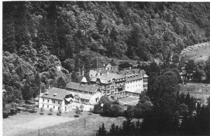
Gesamtansicht von Wildbad Einöd nach den Um- und Erweiterungsbauten unter Georg Schmalzl (1893–1908), Stmk. Landesarchiv.
