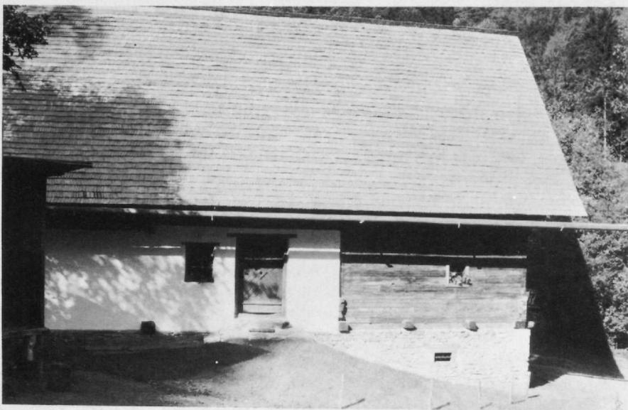
Abb. 4: Traufseite mit Hauseingang und sekundärer Vermauerung.
