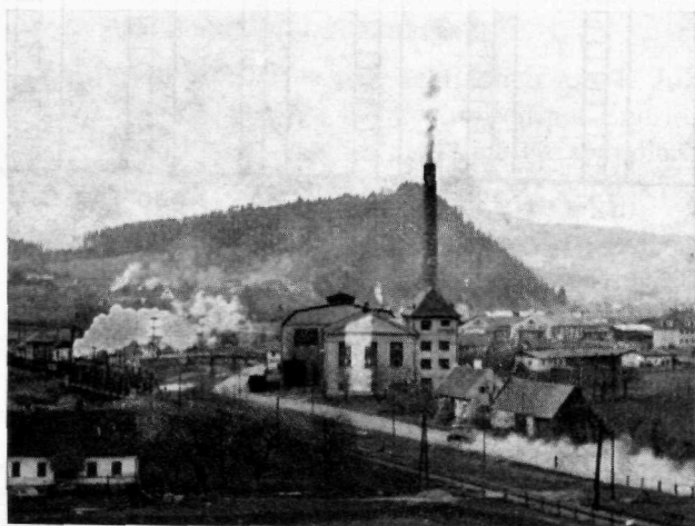
Das Dampfkraftwerk Bärnbach vor der Demontage im Jahre 1943
