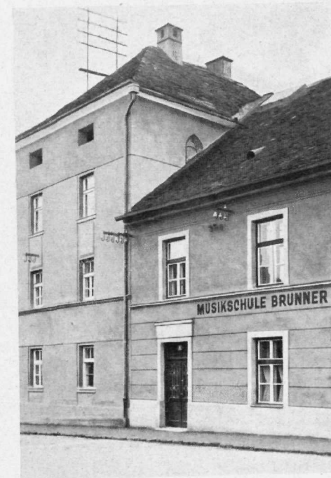
Abbildung 2. Die nordseitige Giebelwand des „Alten Tempels“ mit dem obersten Teil eines gotischen Fensters.
